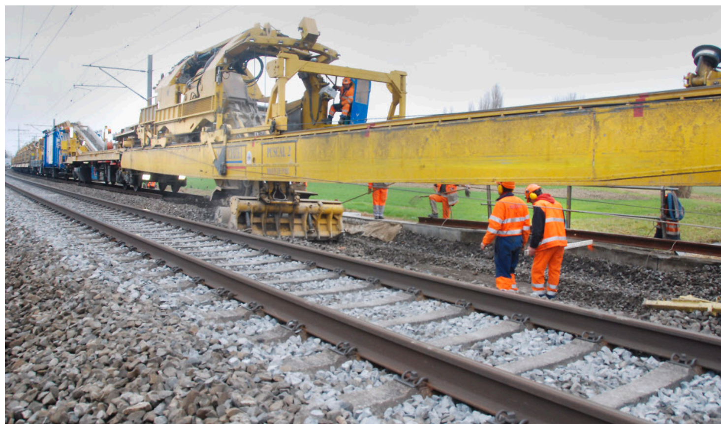
Eine Fabrik auf Schienen: Der Bauzug Pusal 2 hebt die alten Schienen auf der Aaretalstrecke heraus und transportiert sie ab.
